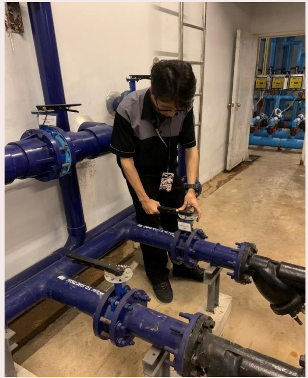
ภาคผนวกที่ 3.26 ตรวจสอบวาล์วเปิด-ปิด ถังเก็บน้ำ
