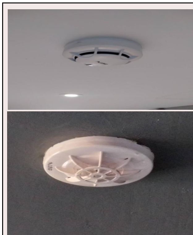
ภาคผนวกที่ 3.43 Smoke&Heat detector
